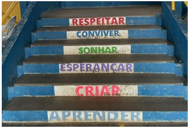
Figura 13 – Escadaria interna do prédio principal
